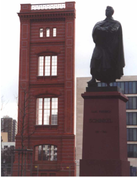
Musterfassade der Bauakademie (Nord-Ost-Ecke) Foto: Renate Schoele
