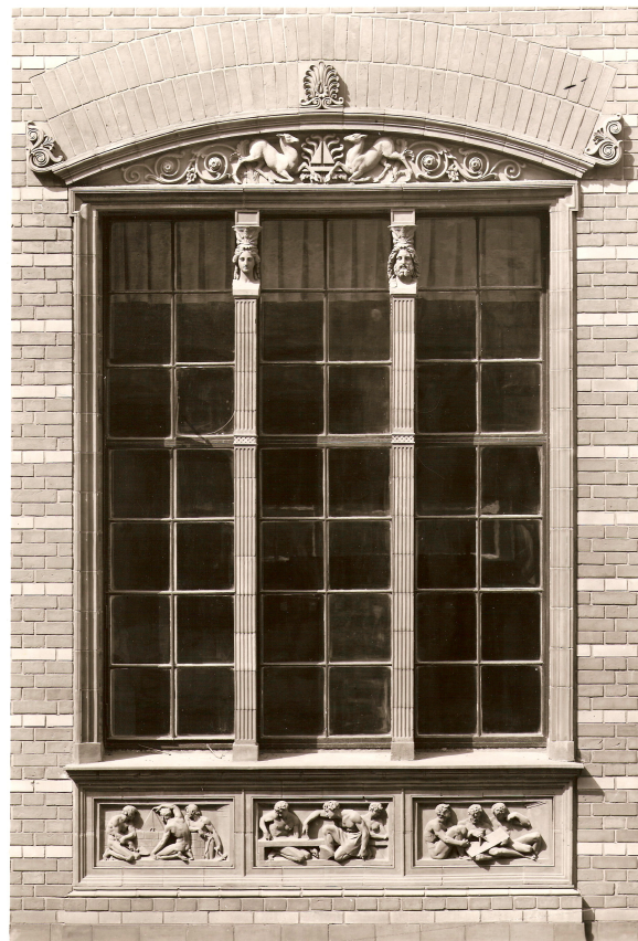
Bauakademie-Fenster, 7. Achse, 1. OG, Messbildfoto, Brandenburgisches Landesamt für Denkmalpflege, Wünsdorf
