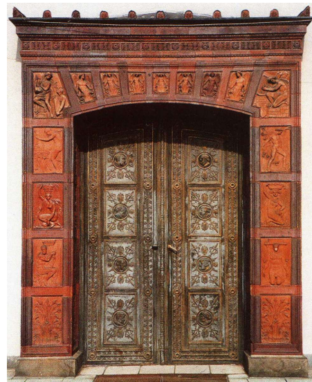
Das linke Portal der Bauakademie wurde 1969 von Karl-Günter Möpert in die ehemalige im Original eingebaut. Die 2. Platte oben rechts stammt jedoch aus dem rechten Portal der Bauakademie. Foto: Renate Schoele
