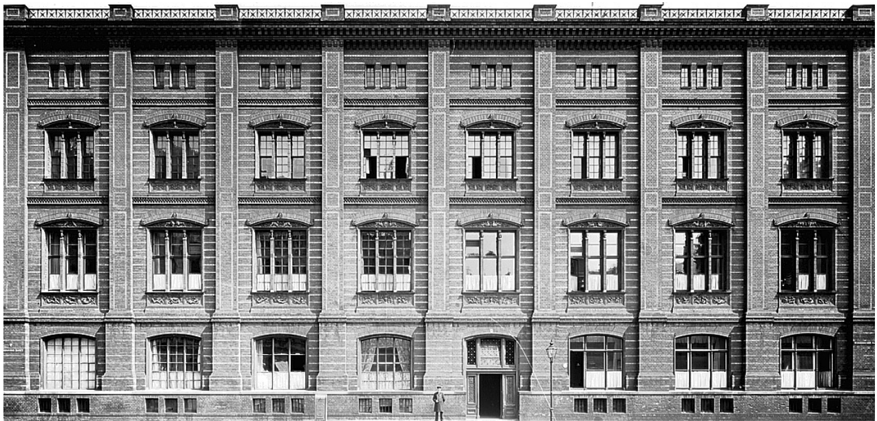
Westseite der Bauakademie (Messbildanstalt, 1911)
