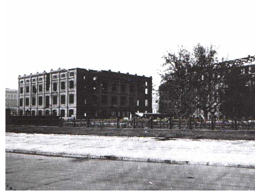
Ruinen der Bauakademie und der Deutschen Industriebank am Schinkelplatz, Foto: Dr.- Ing. Helmut Maier, fünfziger Jahre des 20. Jahrhunderts
