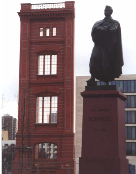
Musterfassade der Bauakademie (Nord-Ost-Ecke), Foto: Renate Schoele
