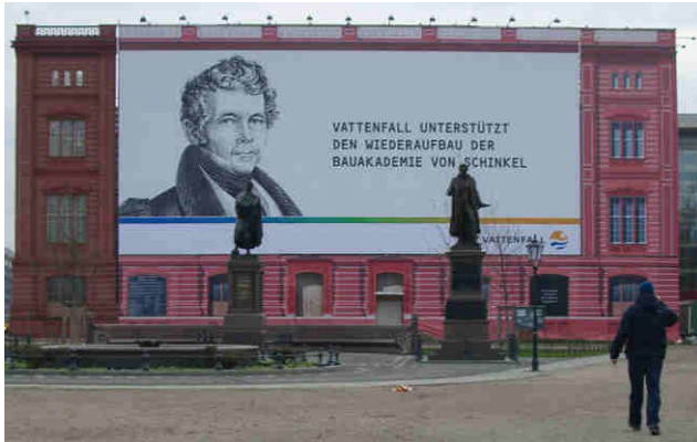
1) Nur die Ecke ist gemauert, der Rest (noch) Attrappe. Im Jul 2011 wurde die Ausstellung „125 Jahre Architekturmuseum der TU Berlin“ in den Musterräumen der Bauakademie eröffnet. Foto von W. Schoele (2008) statt des in TU intern veröffentlichten motivgleichen Fotos
