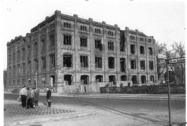
2) Süd-Ost-Fassade der Bauakademie, Foto von Dr. Helmut Maier (1953) statt des in TU intern veröffentlichten motivähnlichen Fotos
