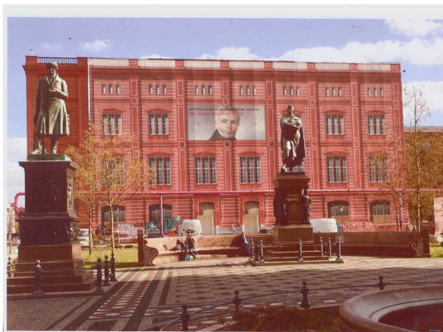
Bauakemiesimulation am Schinkelplatz
