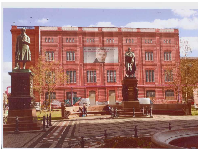
Bauakemiesimulation am Schinkelplatz
