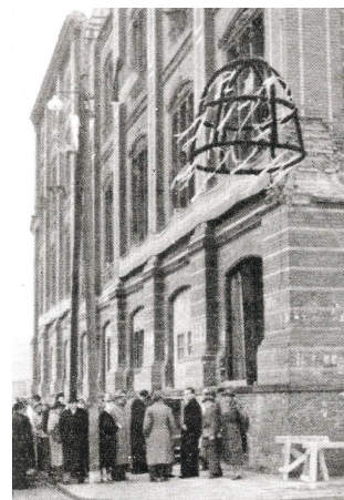
Richtfest (23.11.1953), Foto: IRS, Erkner
