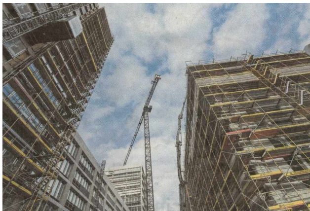
Berlins Baustellen. Im Quartier Heidestrae in Mitte sind seit Jahren groe Baustellen im Gange. Zahlreiche Projekte hatten eine hohe Relevanz fur die Innenstadtentwicklung sagt Berlins Senatsbaudirektorin. Foto: Jans Kalaene – dpa –
