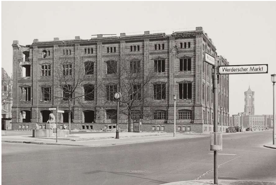
Ruine der Schinkelschen Bauakademie im Jahre 1961, Foto: Landesbildstelle Berlin
