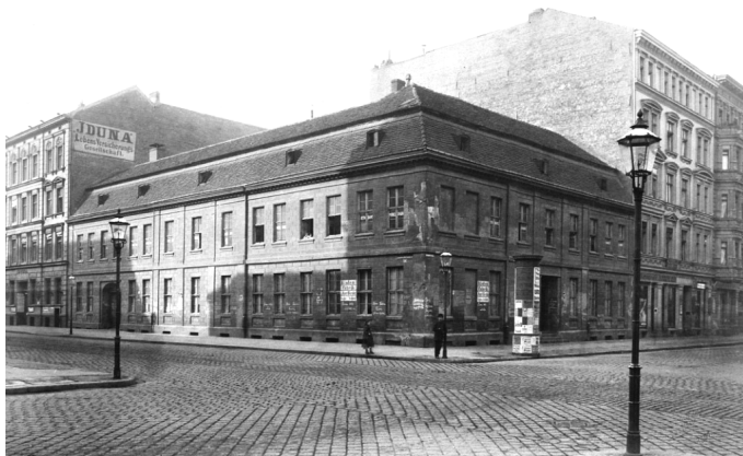
Bauschule 1799, Zimmer- Ecke Charlottenstraße, Berlin-Mitte
