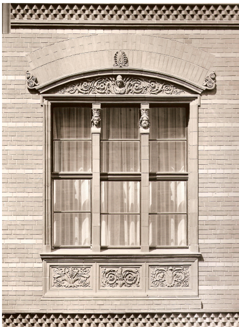
Fenster 2. OG (Achsen 2, 4, 6, 8) Messbildfoto, Brandenburgisches Landesamt für Denkmalpflege, Wünsdorf, Abbildung 21
