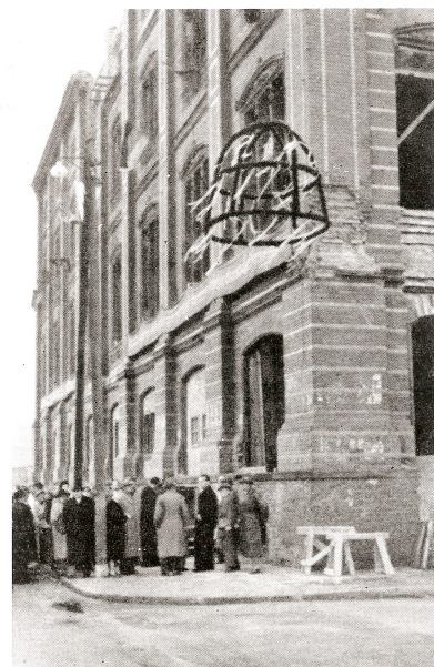
2. Richtfest 1953 (Foto: IRS, Erkner)
