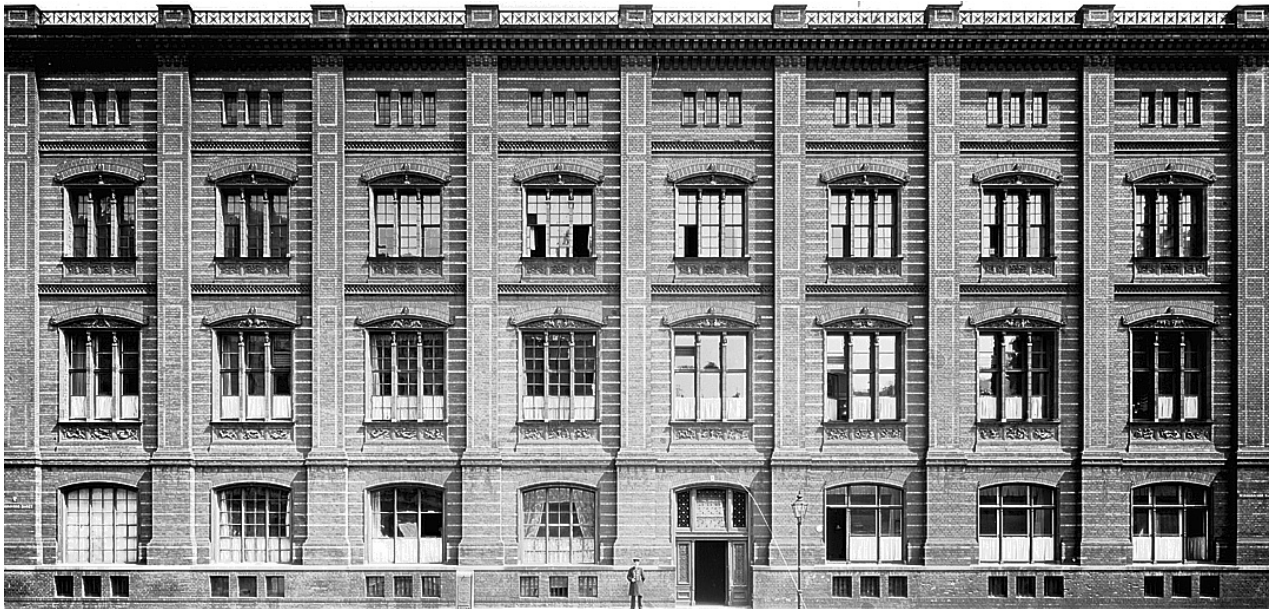
Westseite der Bauakademie (Messbildanstalt, 1911)
